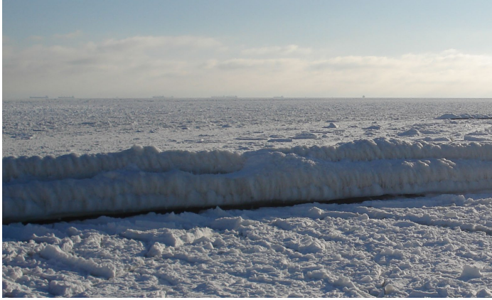
Рис. 2.3. Обледеніння огорожувальної споруди в Одеському порту
