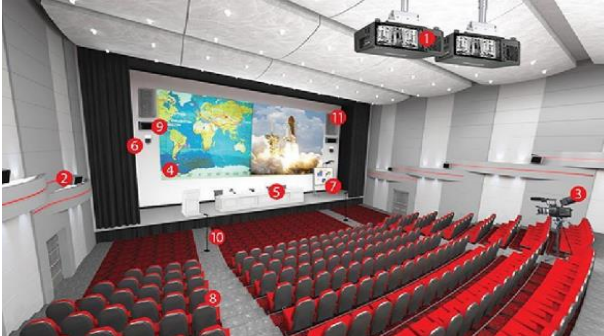
Рисунок 14.1 – Розташування основного обладнання конференц-залу: 1 – відіопроектори; 2 – акустична система навколишнього звуку; 3 – камери ПТС (багатокамерна (від 2 до 8 камер) пересувна телевізійна станція); 4 – екран; 5 – робочі місця президії; 6 – поворотна відеокамера; 7 – інтерактивна дошка; 8 – пульт інтерактивного голосування; 9 – випромінювач бездротової системи синхрперекладів; 10 – мікрофони учасників конференції; 11 – фронтальні акустичні системи
